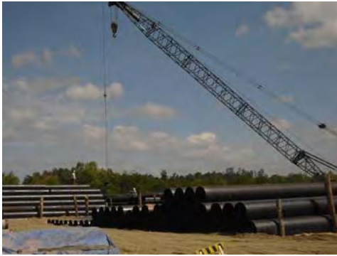
Crane mengangkat pipa dari stock
